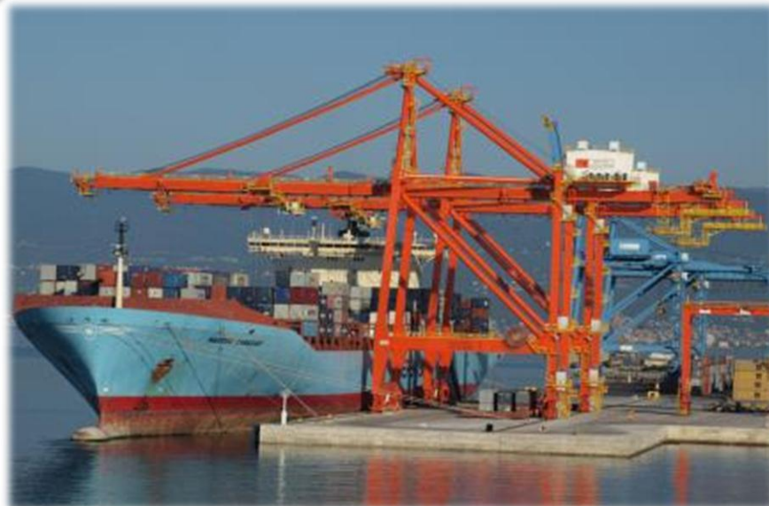
Stanje na gradilištu u Q2 2013.
