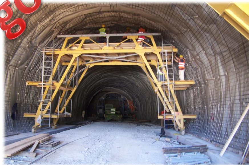
Stanje na gradilištu Q2 2013.
