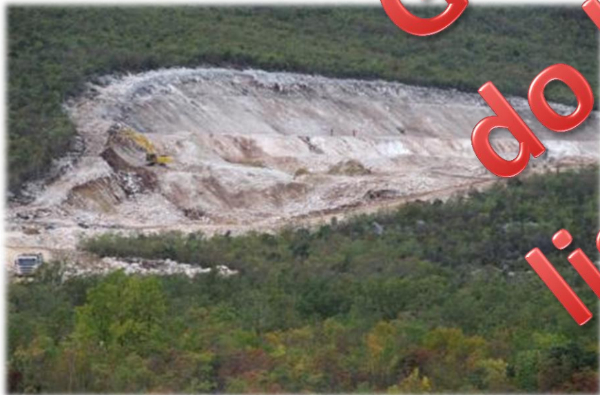
Stanje na gradilištu Q1 2013.
