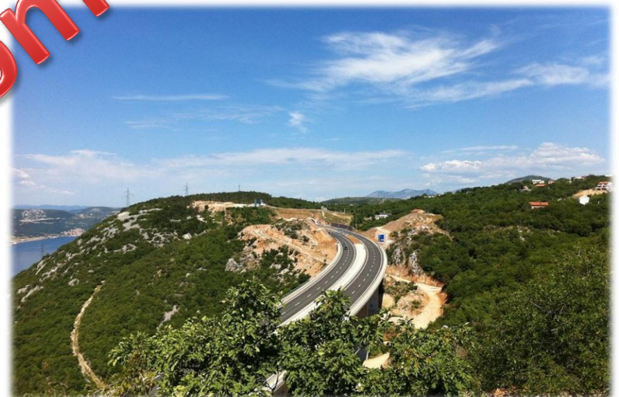
Stanje na gradilištu u 2013.
