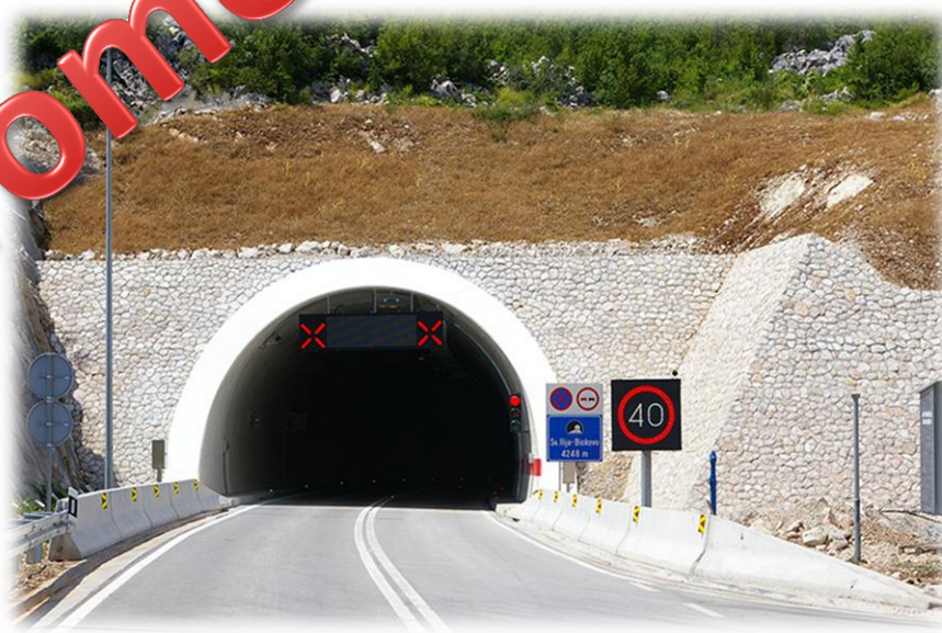
Stanje na gradilištu Q2 2013.
